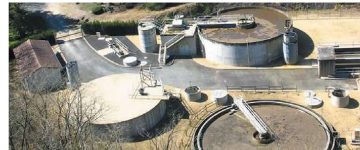
Bassins de décantation de la station d'épuration de Nêris-les-Bains (Allier). En France, la plupart des eaux usées subissent ce type de traitement, au cours duquel certains nutriments sont concentrés dans des boues d'épuration, tandis que d'autres sont volatilisés ou rejetés dans le milieu naturel. Crédits : Toucassé, CC BY-SA, Wikimedia Commons.
